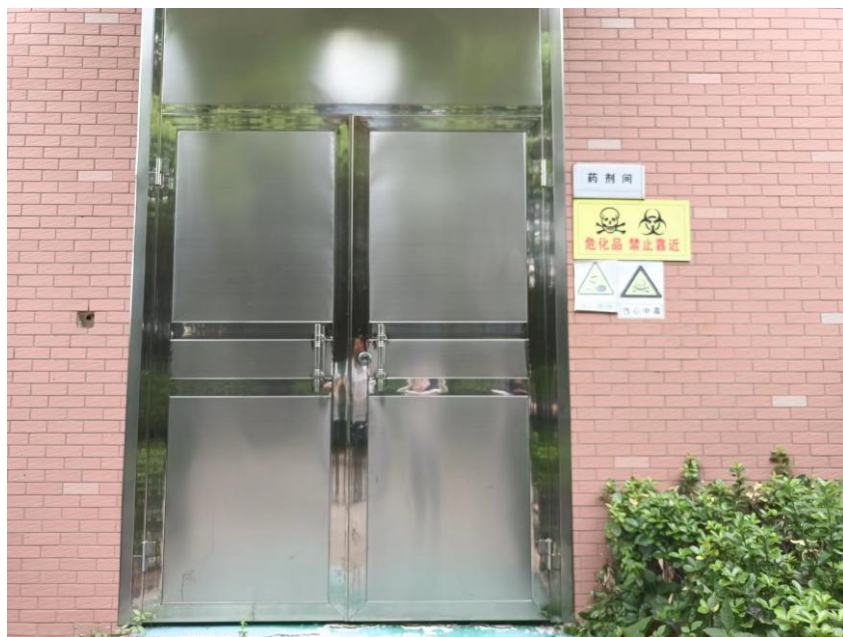
危废暂存仓库
