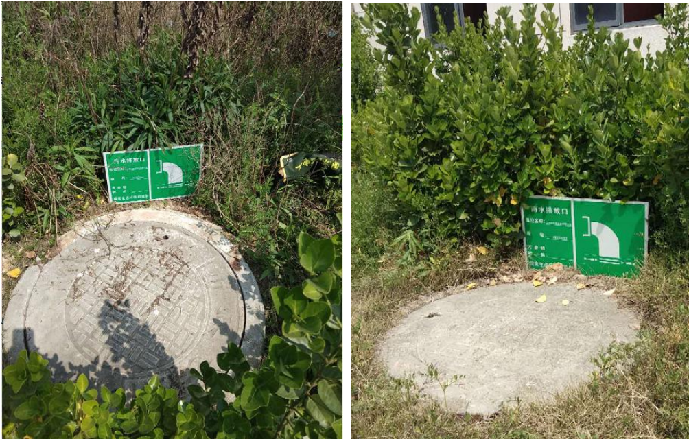
图 3-1 污水、雨水排口标识牌
